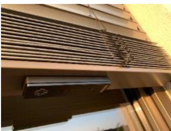
Sobald die LEDs nicht mehr blinken, ist SenSigna fertig kalibriert und es kann eine Funktionsprüfung erfolgen. Dazu die Außenjalousie mehrmals hoch- und tieffahren. Wenn kein Signal ausgelöst wird, den Sonnenschutz tieffahren und Unterschiene ruckartig hochschieben, um einen Alarm zu provozieren. Wenn dieser ertönt, das Signal mithilfe des selbst erstellten PIN-Codes beenden. Der SenSigna ist betriebsbereit.
