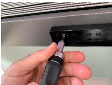
Den Raffstore auf halbe Höhe tieffahren, um die Unterseite leicht erreichen zu können. Motorisierte Produkte von der Versorgungsleitung trennen. Halteschale im Abstand von 300 Millimetern zur Außenkante an die Unterschiene halten und ausrichten. Bohrlöcher markieren und mit einem Bohrer mit zwei Millimetern Durchmesser bohren. SenSigna-
